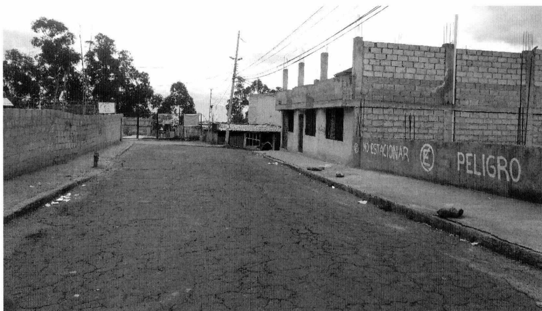
Imagen 2: Tramo asfaltado Calle José Félix Barreiro
