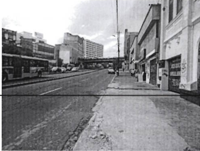
Foto 1.- Av. 12 de Octubre, toma desde la intersección con la Av. Tarqui, sentido norte – sur.
