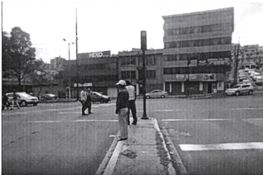
Foto 5.- Av. Tarqui, toma desde la intersección con la Av. 12 de Octubre, sentido oeste - este, en el que se observa un parterre central que permite tener a los transeúntes un refugio a la mitad de calzada y mejora la seguridad vial del cruce peatonal.
