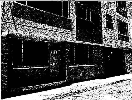
FOTO 3.- VISTA EXTERIOR DE LA EDIFICACION / FACHADA FRONTAL CALLE "N85-B"
