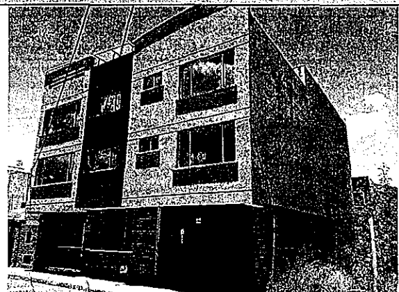
FOTO 2.- VISTA EXTERIOR DE LA EDIFICACION / FACHADA FRONTAL CALLE "N85-B"
