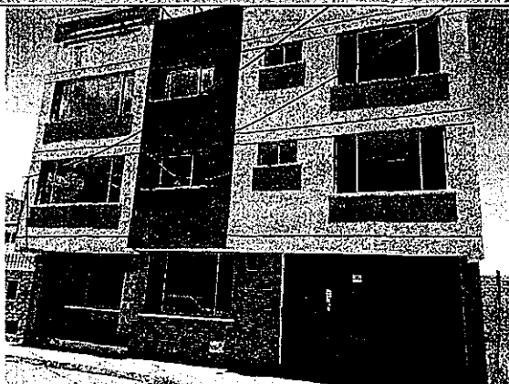
FOTO 1.- VISTA EXTERIOR DE LA EDIFICACION / FACHADA FRONTAL CALLE "N85-B"
