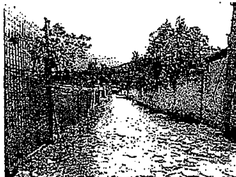
VIA EXISTENTE ABIERTA
