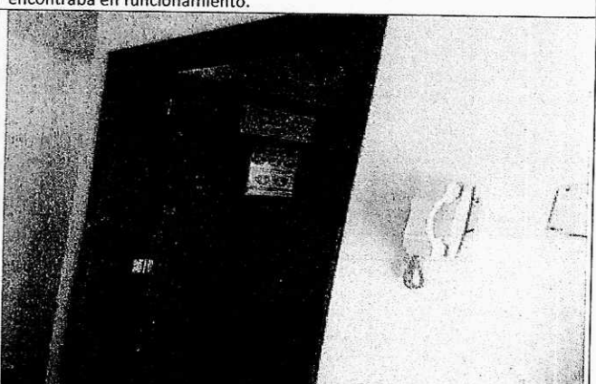
IMAGEN No 4: Se levanta acta de infracción por no contar con la luae vigente".
