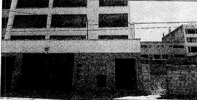
Imagen No. 1: Fachada principal del establecimiento visto desde la calle Miguel Zambrano, el mismo que no cuenta con un letrero de identificación.
