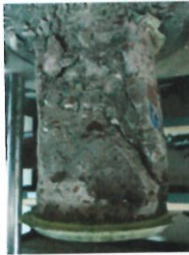
Figura 21: Ensayo de compresión simple muestra frontal capa externa Abs 0*420 Hastal sur
