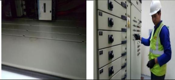
Se procede a tomar medidas de temperatura en los terminales del contactor con el termógrafo y medidas de voltaje con el multímetro.
