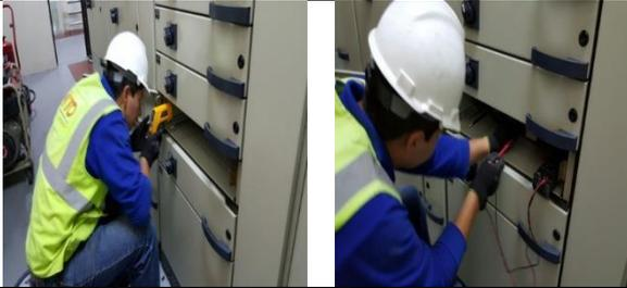
Nuevamente se procede apagar desde el selector de control de iluminación ubicado en el tablero +n04 y desde el breaker termo-magnético.
