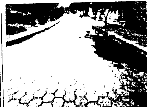
Fotografía No. 11 RE ADOQUINADO Y CORRECCIÓN DE PENDIENTE
