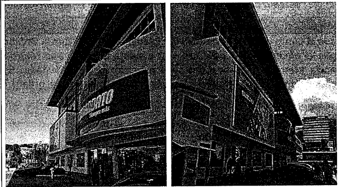
Fotos N°2 : Imágenes de fachada frontal norte
