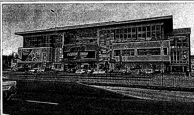
Foto N°1: Estado de la edificación
