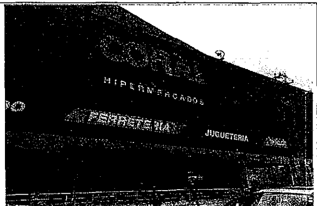
FOTO 2: VISTA DE LA FALTA DE LMU20, POR EL LEVANTAMIENTO DE DOS SUBSUELOS Y DOS PLANTAS
