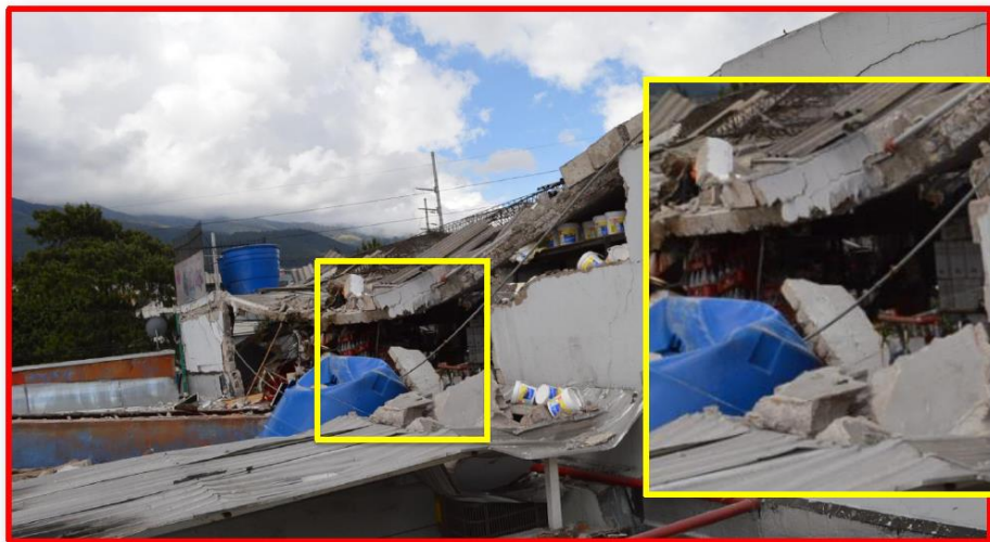
UBICACIÓN DE LA CENTRALITA CLANDESTINA VISTA EXTERIOR SUR, Detalle
