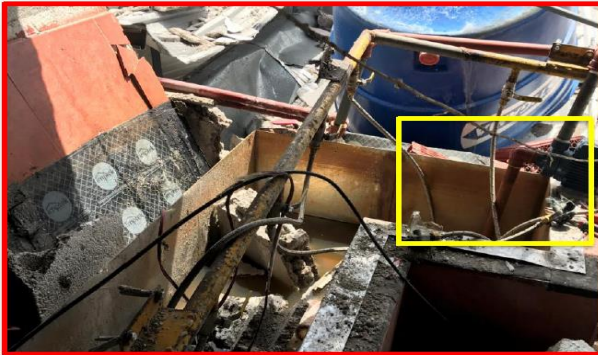
BOMBA ELÉCTRICA JUNTO A LA CENTRALITA CLANDESTINA
