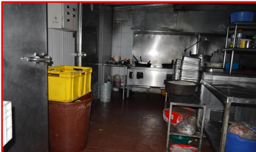
ÁREA DE COCINA PRIMERA PLANTA SIN DAÑO ESTRUCTURAL
