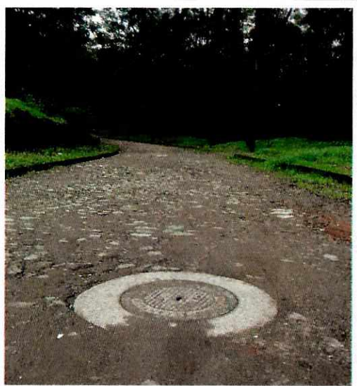
Pozo de alcantarillado
