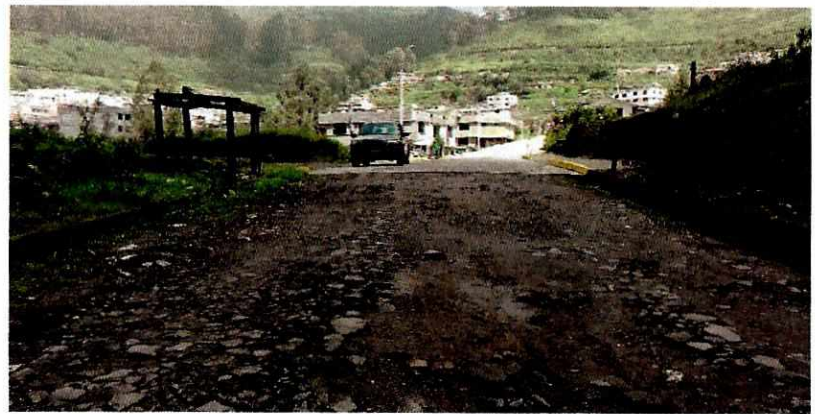
Empate con adoquinado en barrio San Fernando
