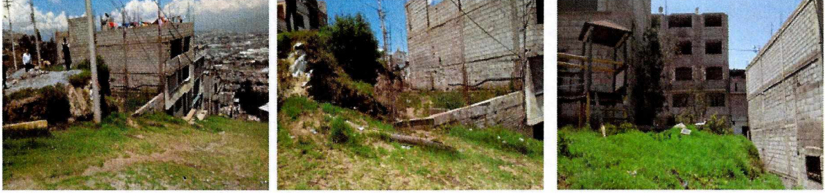
8.1.3 Servicios básicos en el sector existentes
