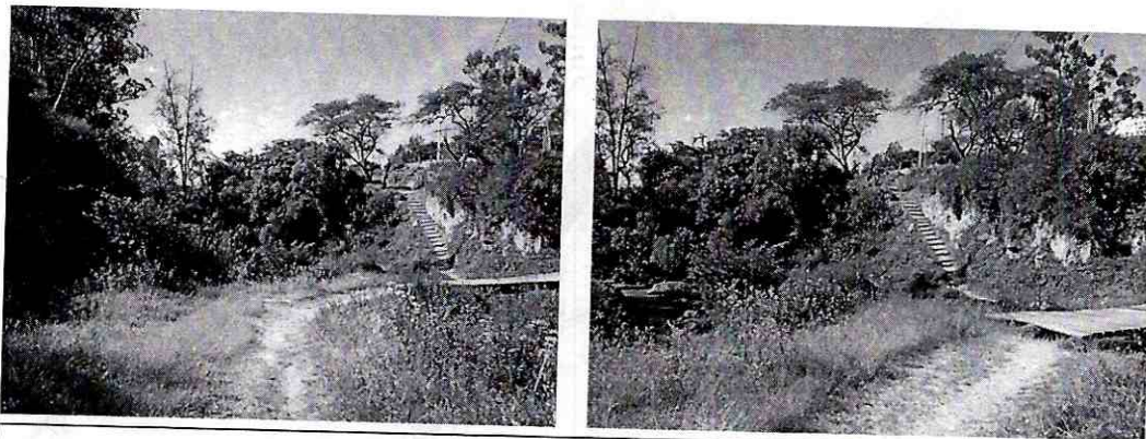
Fotografías del estado actual del puente peatonal
