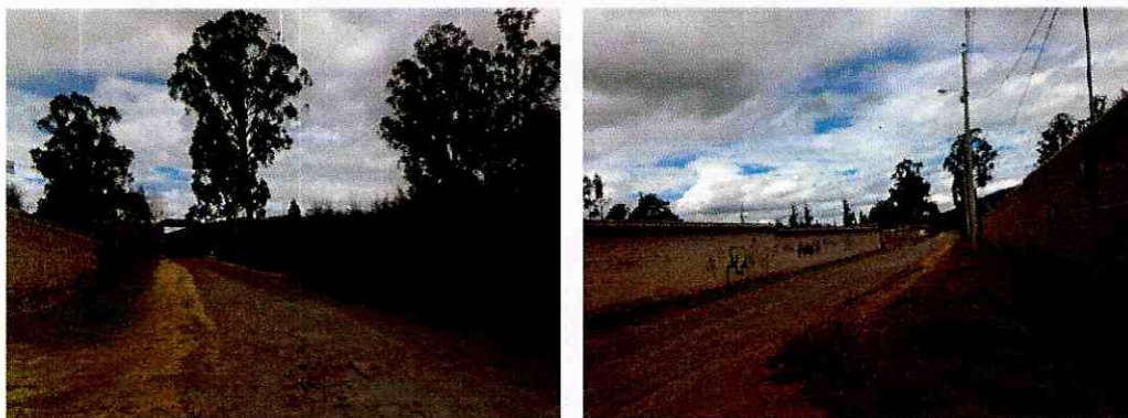
FOTOGRAFÍAS DE LA INSPECCIÓN REALIZADA 18/06/2015
