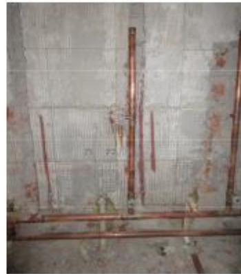
Tuberías de baterías sanitarias deterioradas - Se cambiaron las tuberías de las baterías sanitarias así como la circulación de las mismas.
