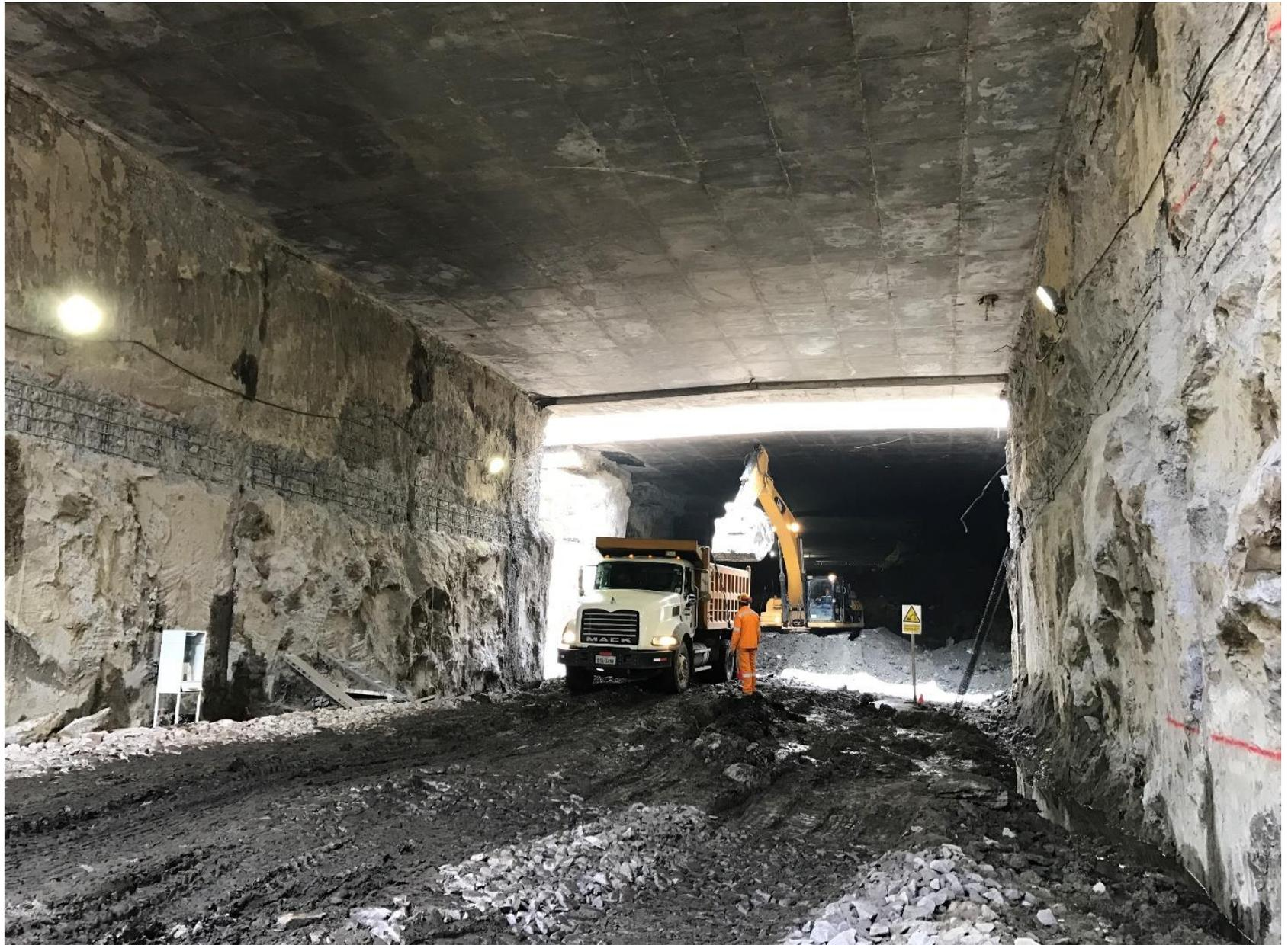
Finalizadas pantallas y losas, completamente excavada. Pozo de ataque de 2 tuneladoras, una 100% montada (Luz de América) y otra en proceso (La Carolina)
