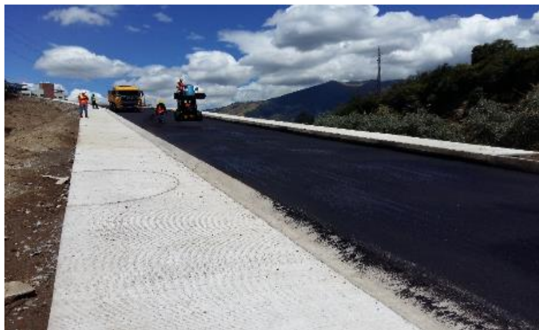
PAVIMENTO, ASFALTO EMULSIONADO PARA RIEGO DE ADHERENCIA FASE I – PROCESO CONSTRUCTIVO
