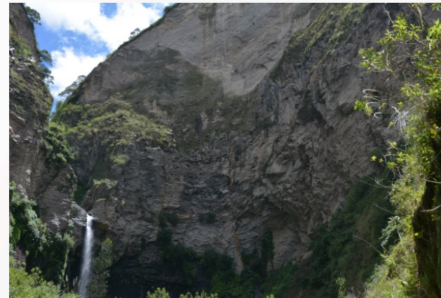
Talud zona del puente
