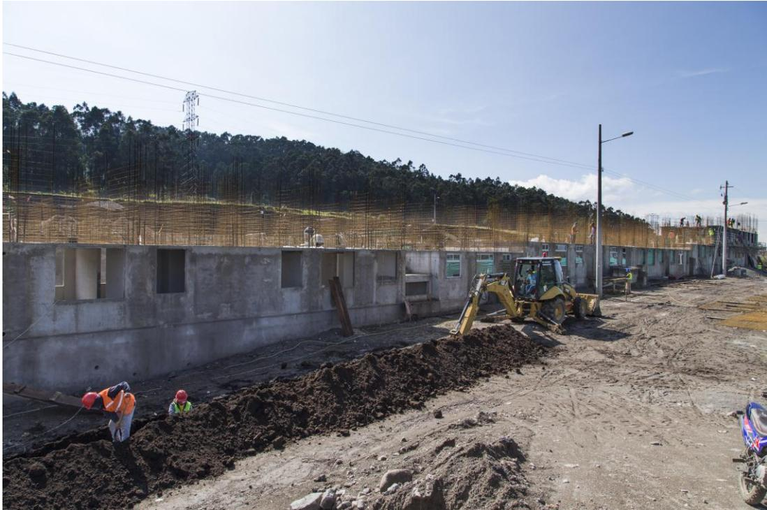
Es un sistema estructural, pueden observar la riqueza del sistema estructural; es un sistema de malla continua, son muros portantes de diez centímetros de hormigón, me parece que aquí hay una tecnología constructiva muy solvente, a diferencia de otras áreas en el sur de Quito que sí tuvieron resquebrajamientos, por ejemplo en Turubamba. Entonces, ésta es la demostración de la inversión y de la responsabilidad profesional, en este caso, de Ferroinmobiliaria.
