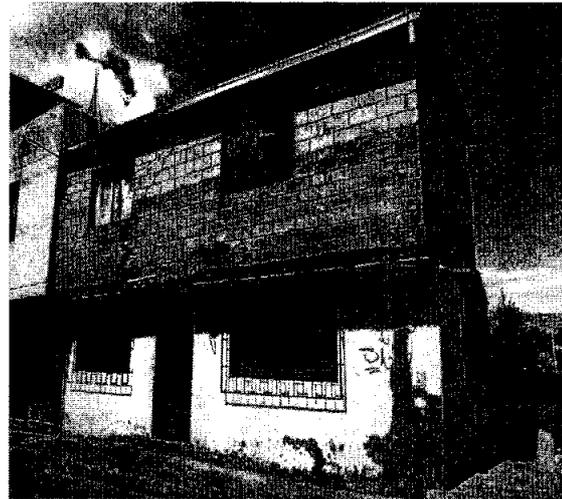
Borde de la quebrada de relleno y fisuras de la edificación
