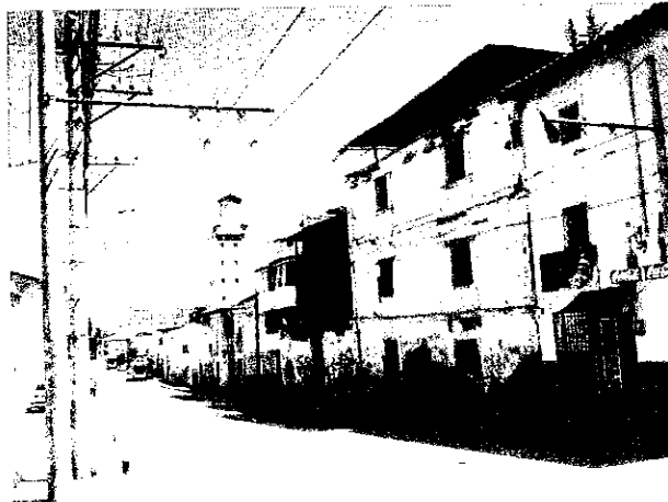
Vista del tramo Av. Maldonado en donde se encuentra la edificación.
