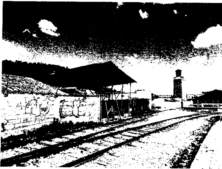
Vista posterior de la edificación desde la estación de trenes de Chimbacalle.
