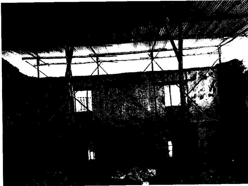
Vista al interior de la edificación
