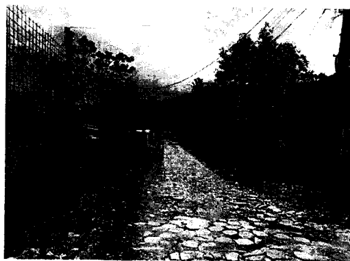
VIA EXISTENTE ABIERTA
