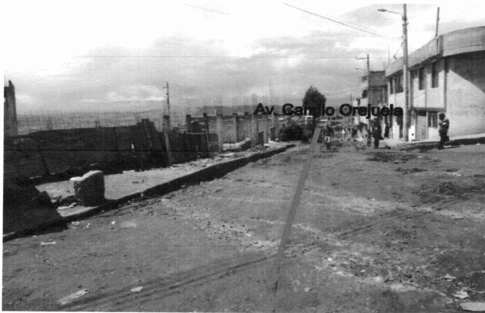
Vía que inicia en la Av. Camilo Orejuela
