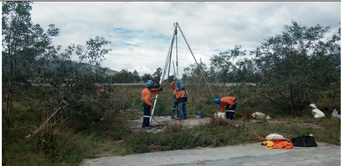
Foto 26. Pozo de perforación PP-26
