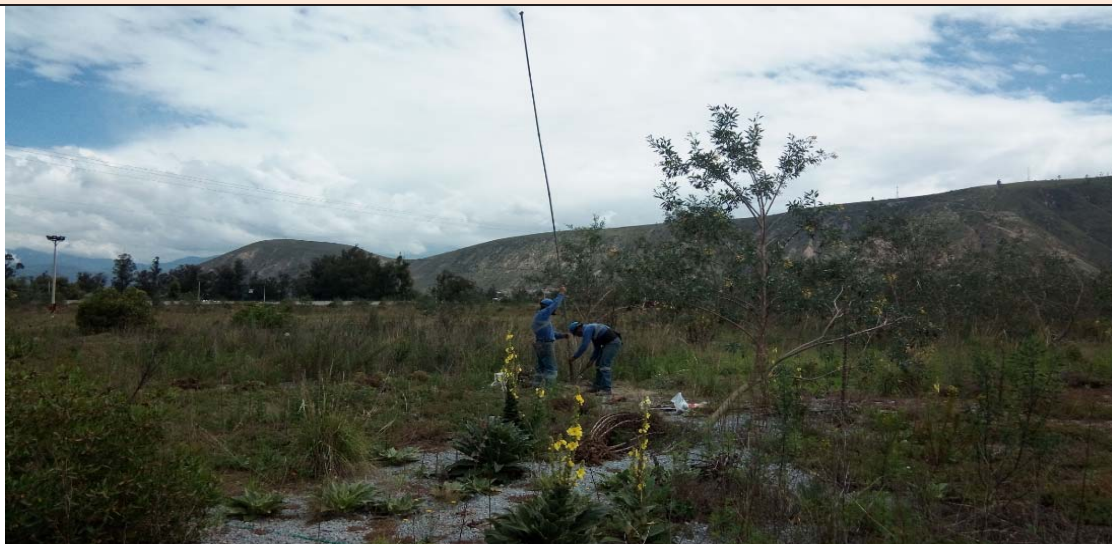
Foto 11. Pozo de perforación PP-11
