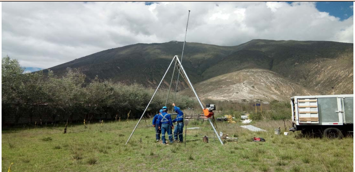
Foto 14. Pozo de perforación PP-14
