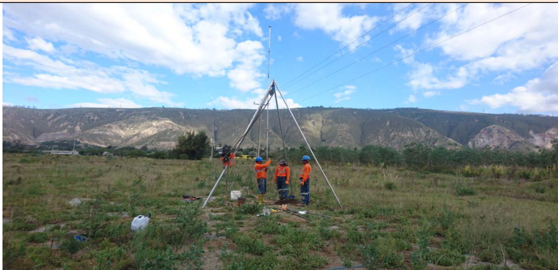
Foto 21. Pozo de perforación PP-21
