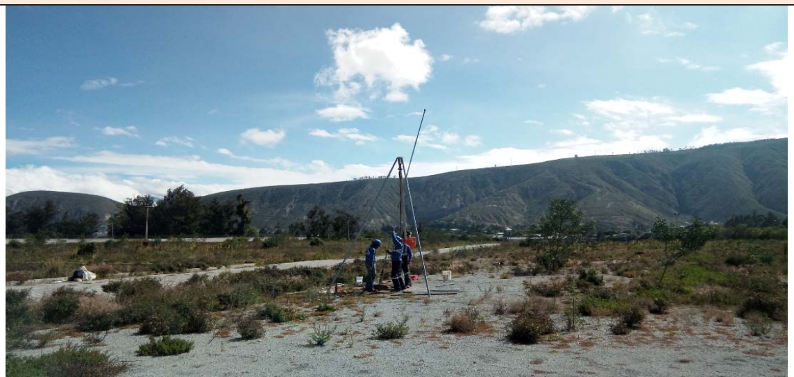
Foto 3. Pozo de perforación PP-3
