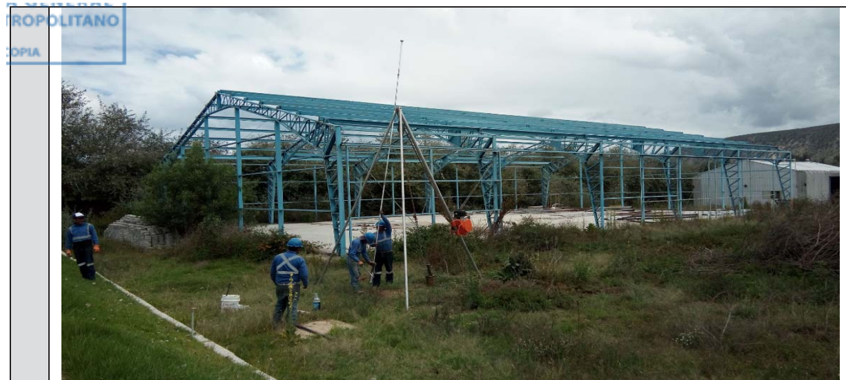
Foto 1. Pozo de perforación PP-1
