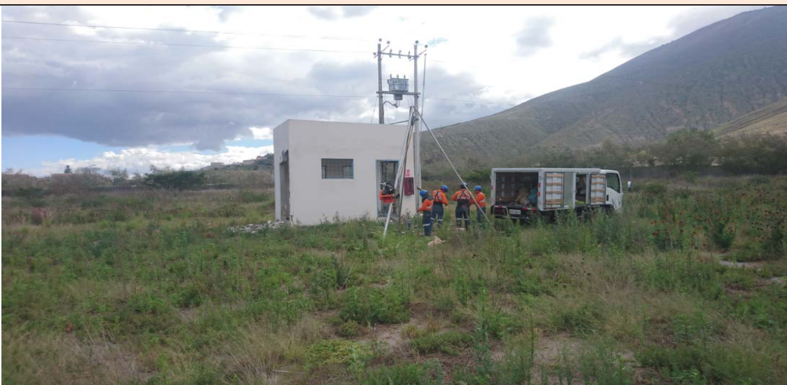
Foto 27. Pozo de perforación PP-27
