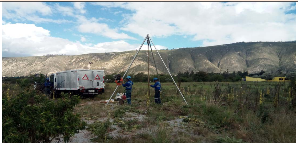
Foto 8. Pozo de perforación PP-8
