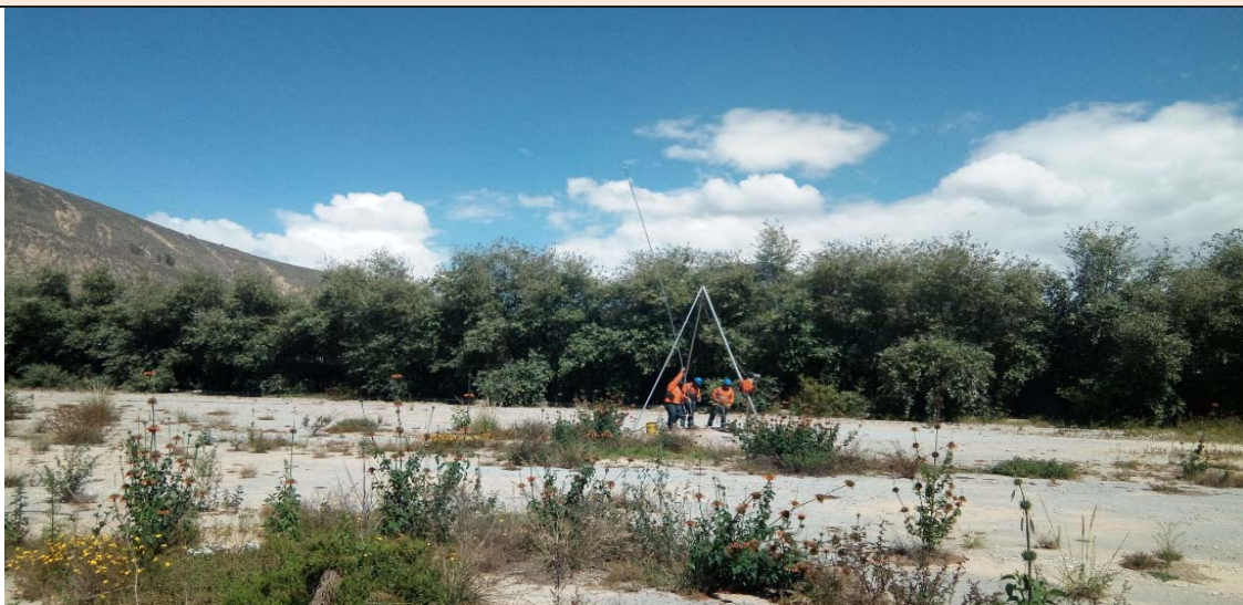
Foto 18. Pozo de perforación PP-18
