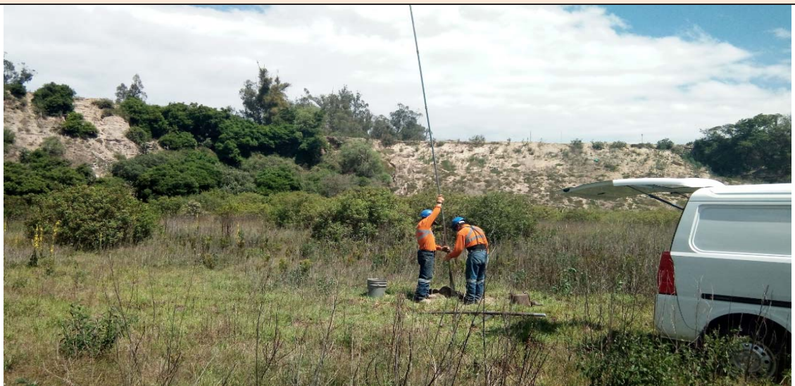
Foto 15. Pozo de perforación PP-15
