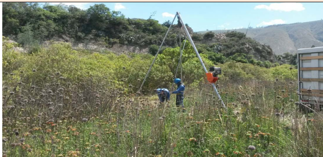
Foto 30. Pozo de perforación PP-30
