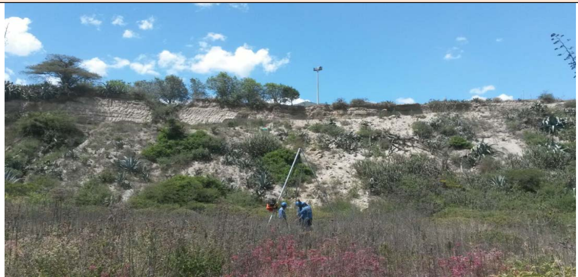
Foto 23. Pozo de perforación PP-23
