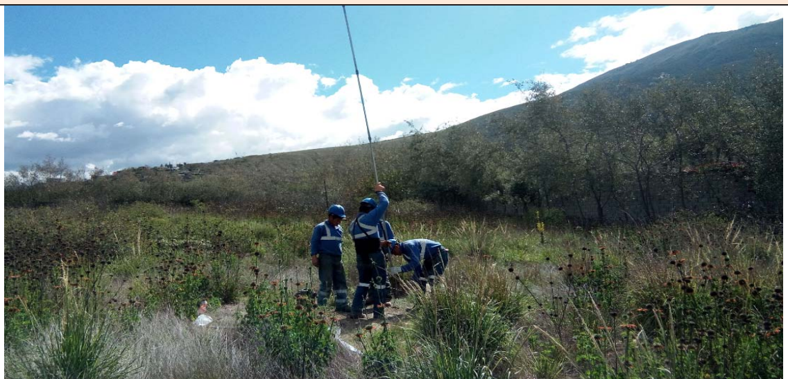
Foto 9. Pozo de perforación PP-9
