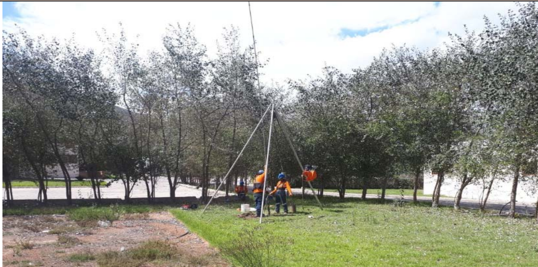
Foto 17. Pozo de perforación PP-17
