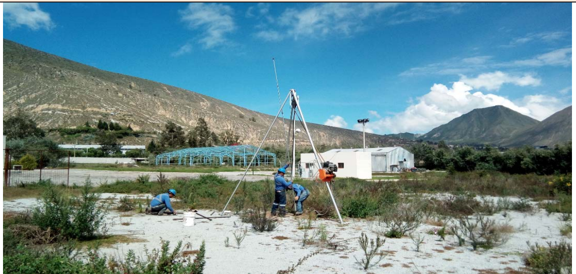
Foto 2. Pozo de perforación PP-2
