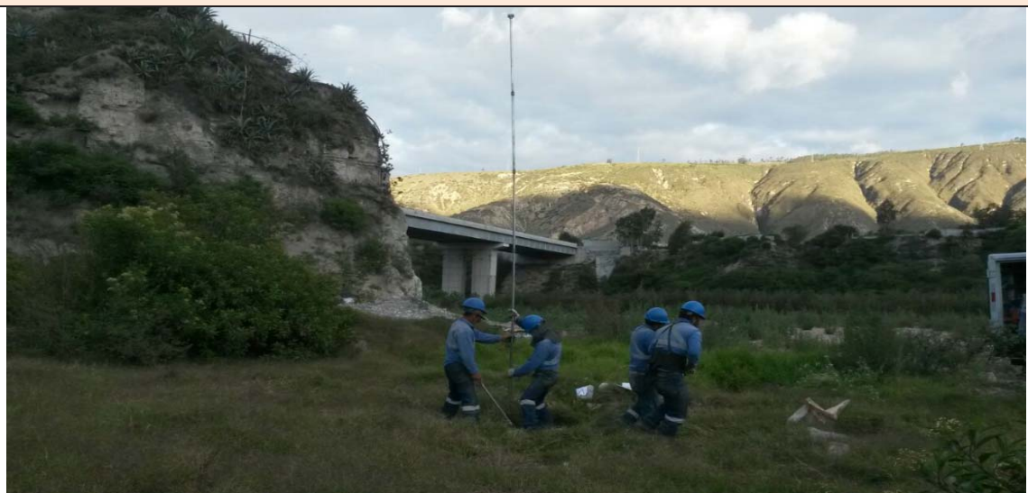
Foto 24. Pozo de perforación PP-24
