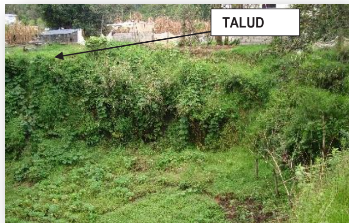
Figura 17: Panorámica de la definición de talud
