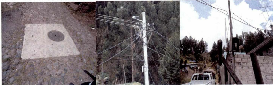
8.1.3 Servicios basicos en el sector existentes
