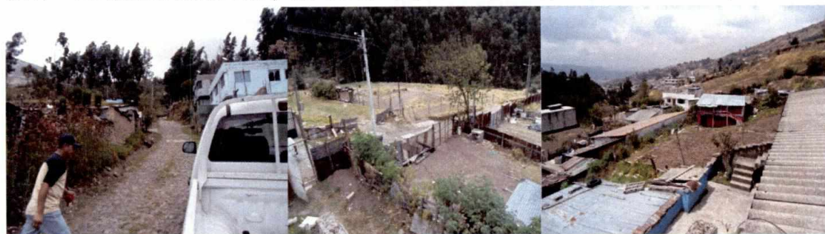
8.1.4 Pendiente del sector y uso del suelo ( construcción y cortes del terreno)
