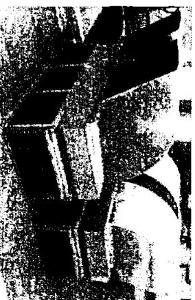
Instalación de protección a sistema condensadoras para protección ante posible ceniza volcánica
