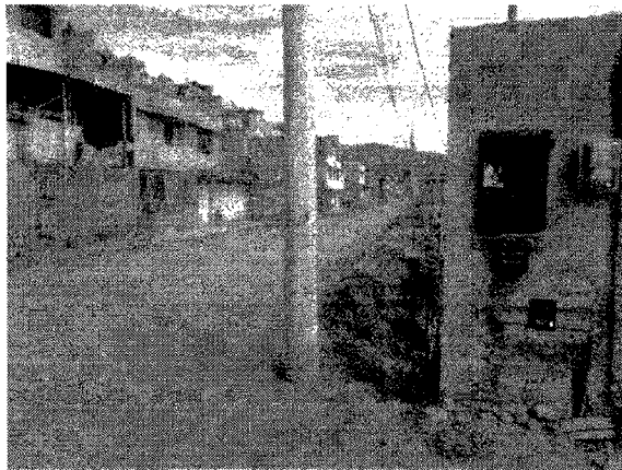
AGUA POTABLE y LUZ ELECTRICA
