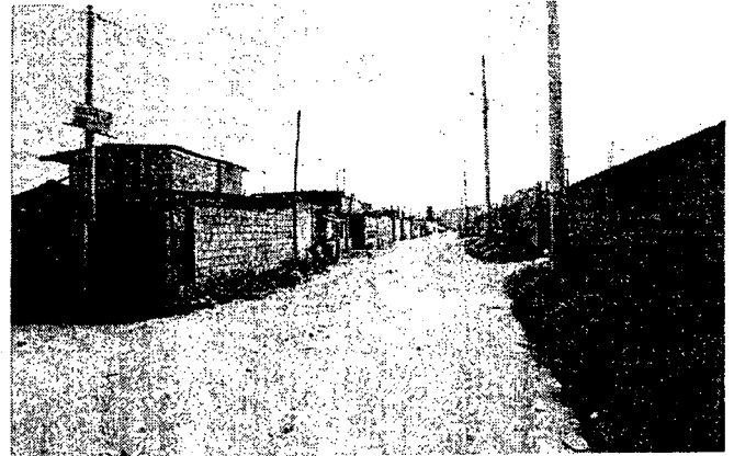
ESTADO ACTUAL CALLE EL MERCURIO
