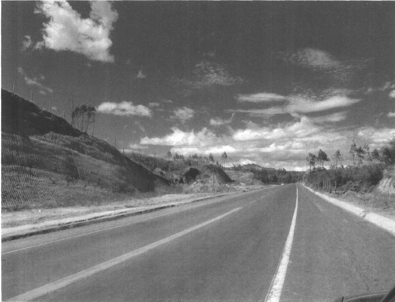
Talud y ampliación de la vía E-35 ; hacia el lado izquierdo lo que sería el lindero de los lotes 12 y 11 ; en el fondo lo que sería la zona administrativa y comercial, vista de Oriente a Occidente.
