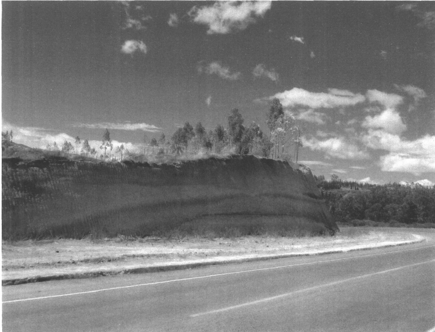
Ampliación vía E-35 (con vista hacia el Sur-Occidente) – La parte superior del talud corresponde a lo que sería los lotes 13 y de equipamiento Municipal
