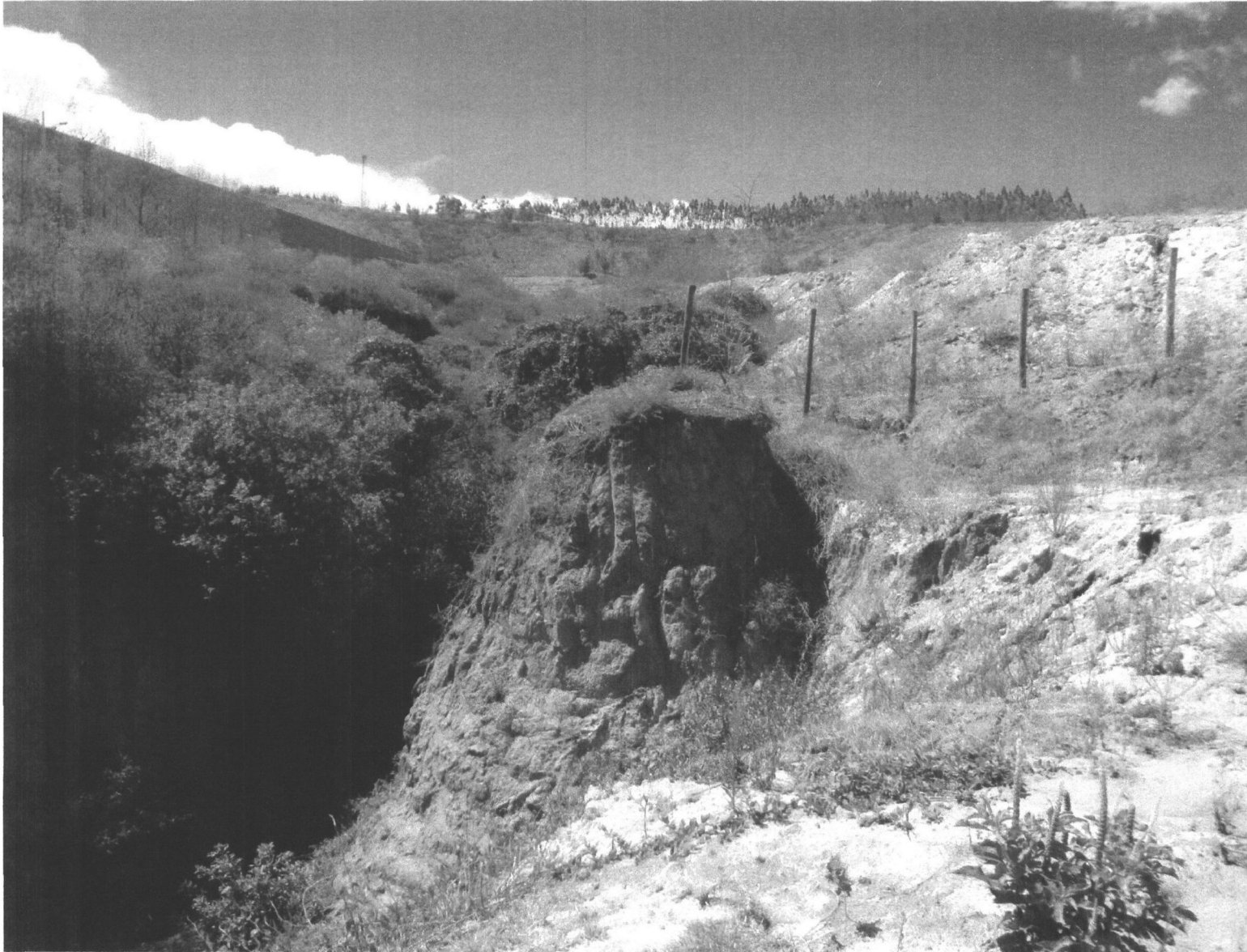
Vista hacia el Sur de la quebrada Huaranga Loma en el sitio de la descarga del alcantarillado
