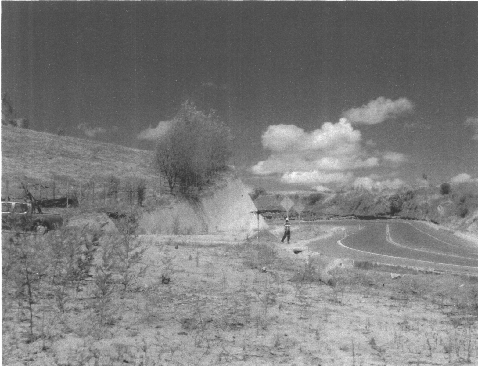
Vista de la vía E-35 con el talud de lindero Norte del PIQ, tomada desde el lindero Oriental próximo a la quebrada Huaranga Loma.
