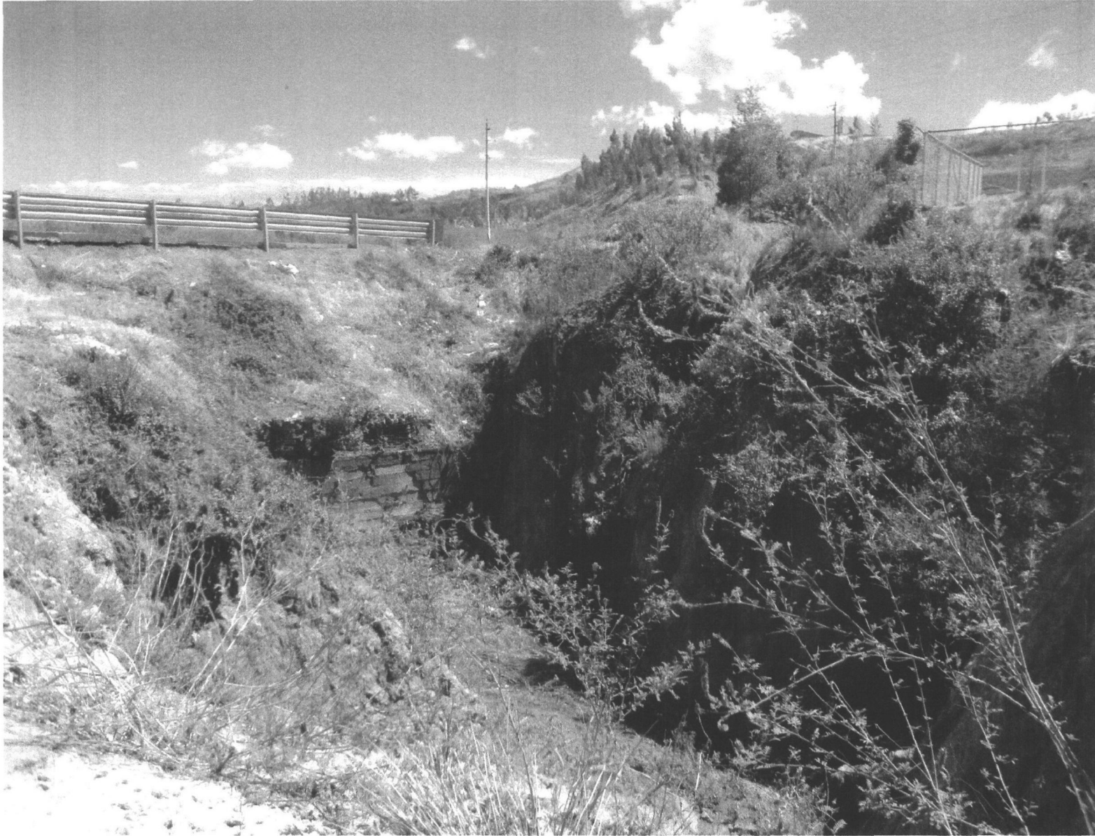
Vista hacia el Norte de la quebrada Huaranga Loma en el sitio de la descarga del alcantarillado
