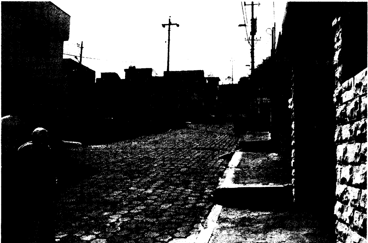
VISTA DE LA CALLE PRINCIPAL O ADOQUINADA Y CON ACERAS
