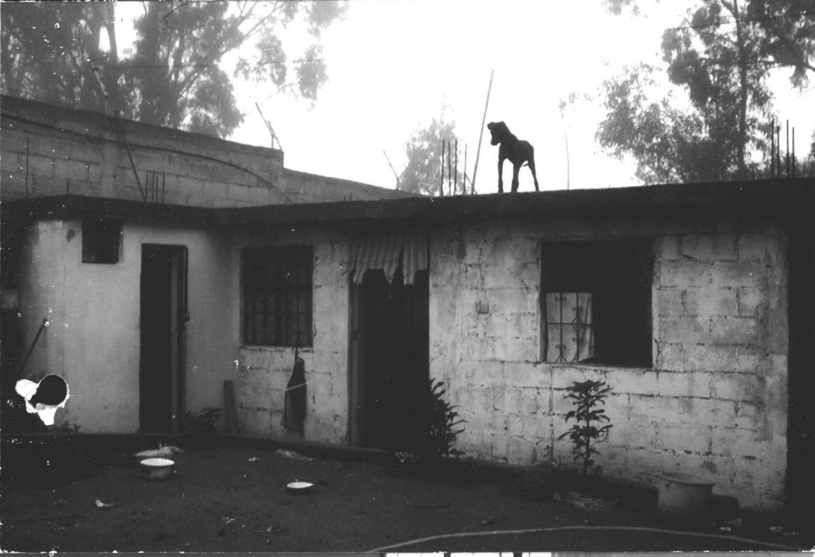
Parte Posterior de la construcción.
