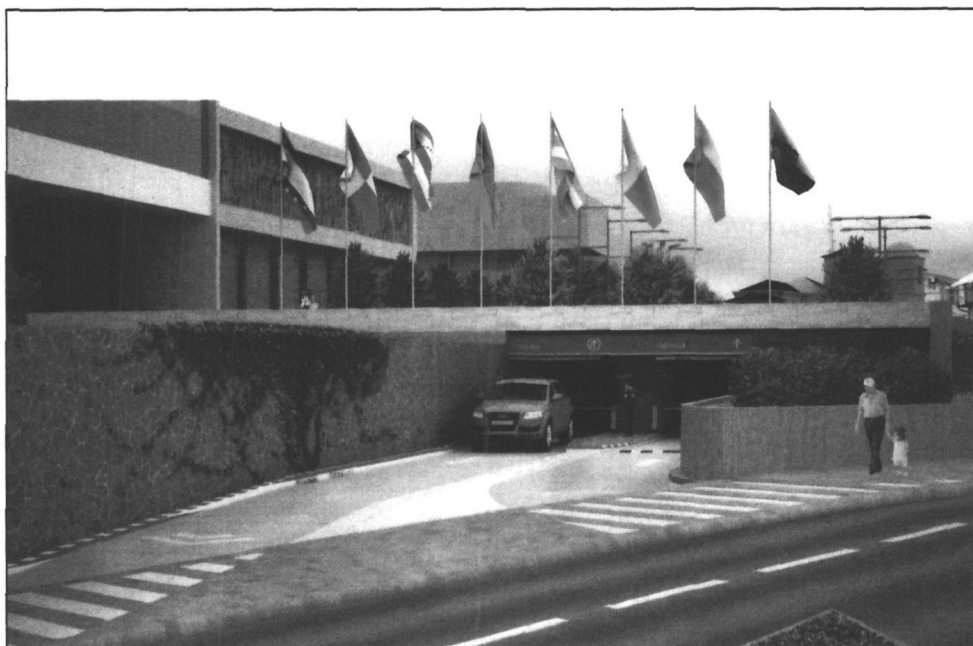
COMPLEJO LEGISLATIVO: Vista acceso al bloque De parqueaderos desde la Av. Juan Montalvo
