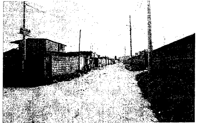
ESTADO ACTUAL CALLE EL MERCURIO
