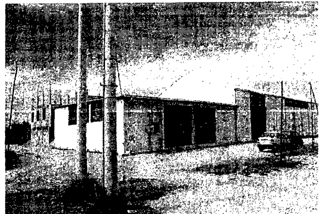
CALLE ACCESO PRINCIPAL
