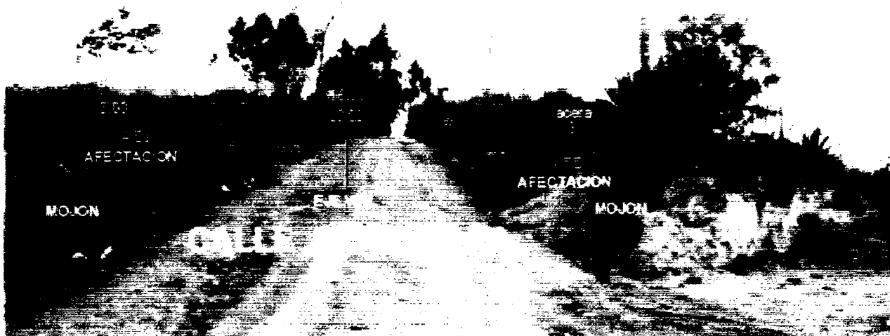
FOTO 3.- CALLE "ATAHUALPA" 16.0m. (vista de norte a sur) AFECTACION VARIABLE DE 4.55 m al lado Oeste y 4.51 m al lado Este puntos de referencia: Eje vial y Alambrada
