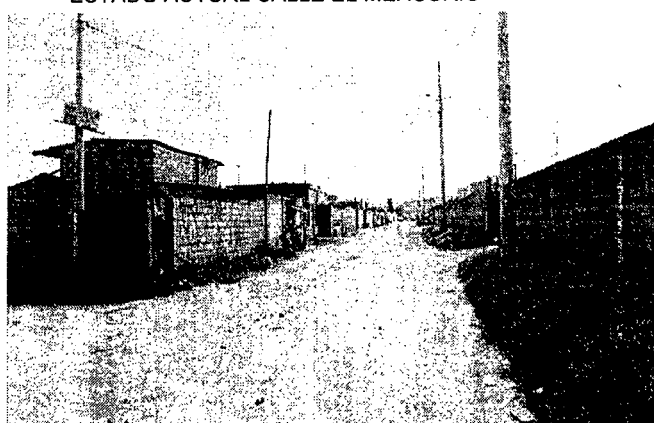
ESTADO ACTUAL CALLE EL MERCURIO
