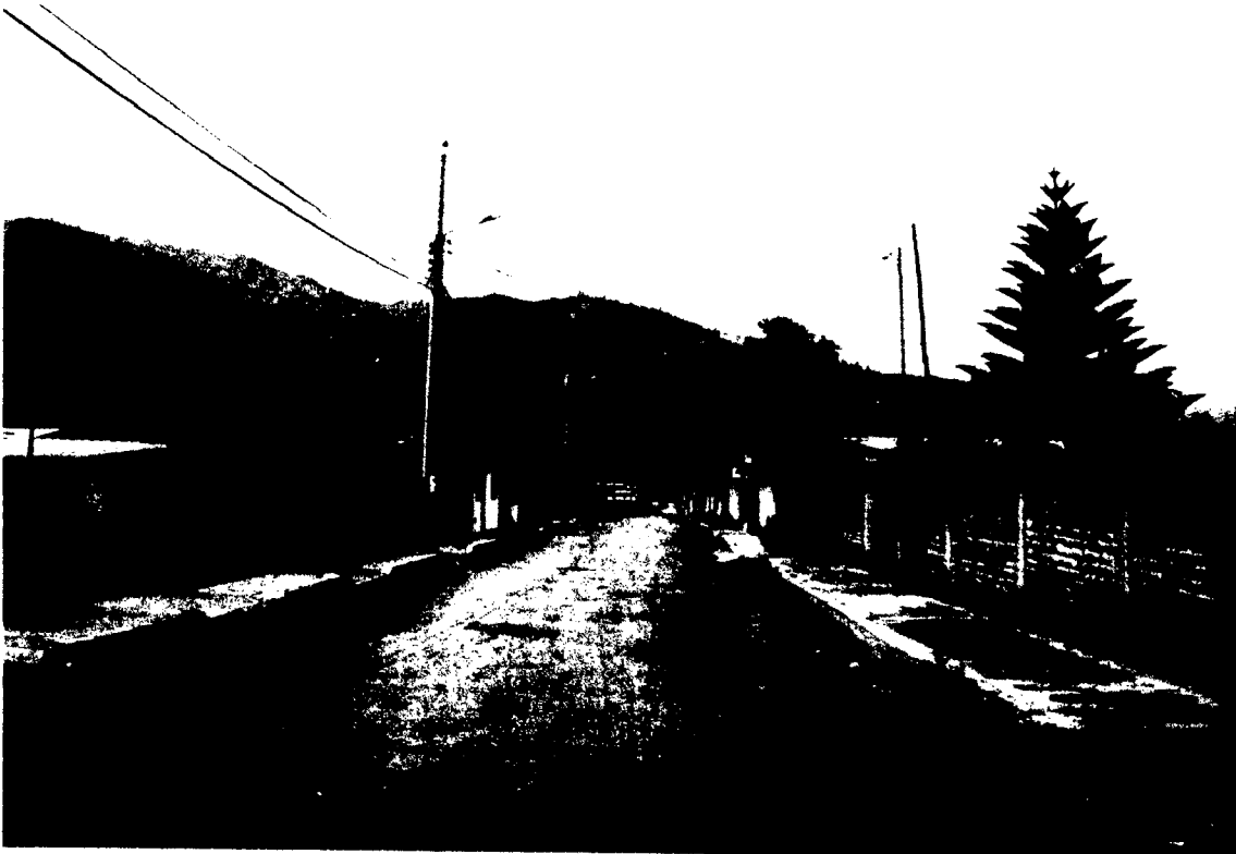
CALLE LONGITUDINAL INTERIOR EN LA PARTE SUR DEL PREDIO. SE NOTA LA FALTA DE ACABADO DE VÍA. FOTO N° 4
