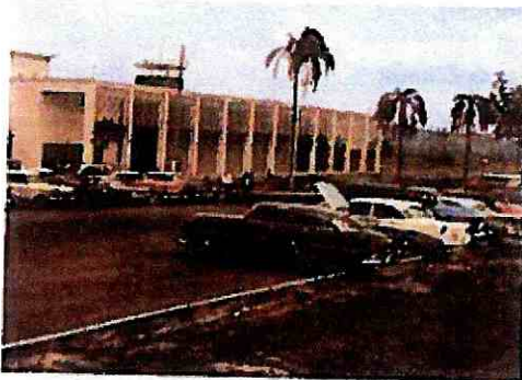
Fotografías de la Terminal Aérea Original, año 1960
