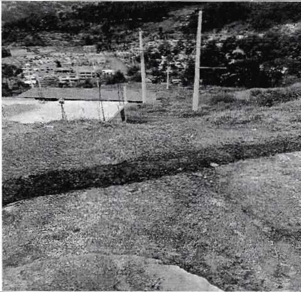
F01.- Vista de calle proyectada en tierra con lastre.
