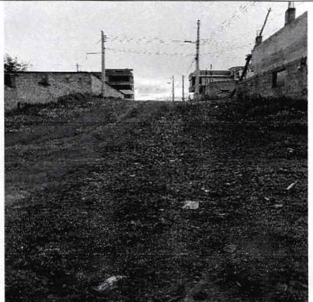
F02.- Vista Calle Vista Hermosa, en tierra sin bordillos, aceras, con servicios y alumbrado público.
