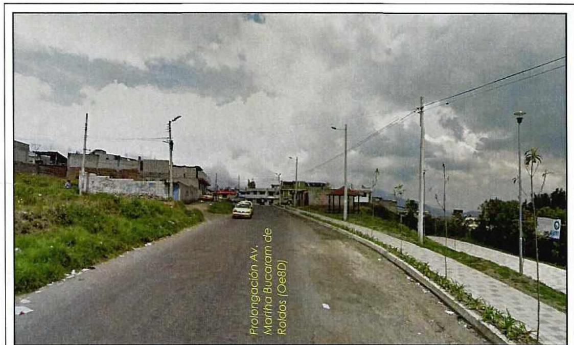
Figura 2. Bordillo, acera, sendero peatonal, cerramiento de malla, y pérgola de madera construida en la parte oriental a la vía.
