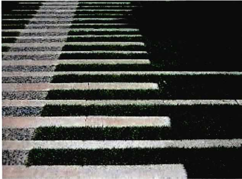
Imagen N° 25: Pavimentos permeables y ecológicos
