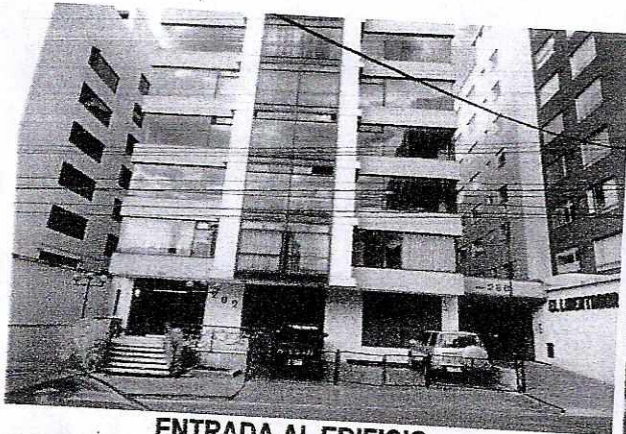
ENTRADA AL EDIFICIO
