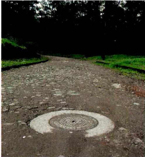
Pozo de alcantarillado
