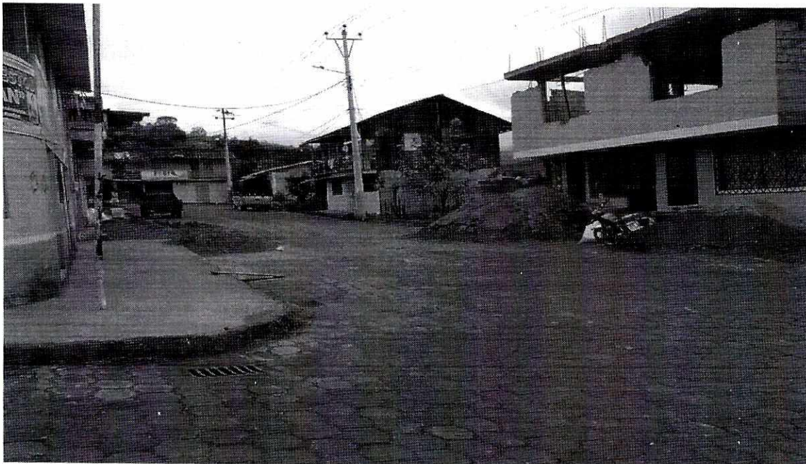
Estado actual Calle Quito
