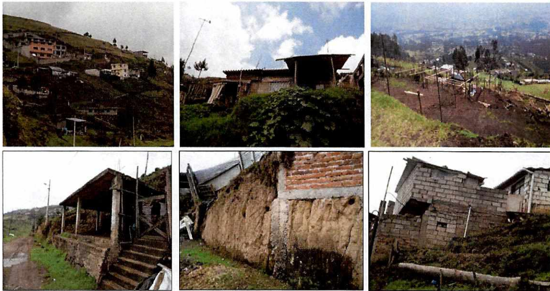
8.1.3 Servicios básicos en el sector existentes
