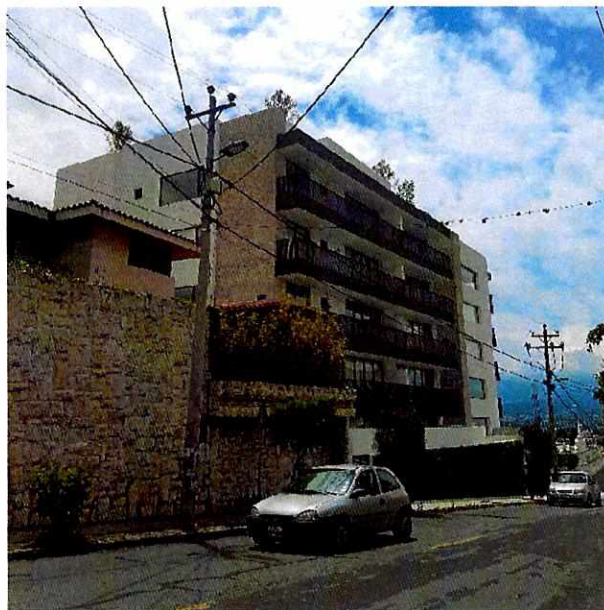
Foto N° 1.- Vista frontal Edificio SAKURA.
