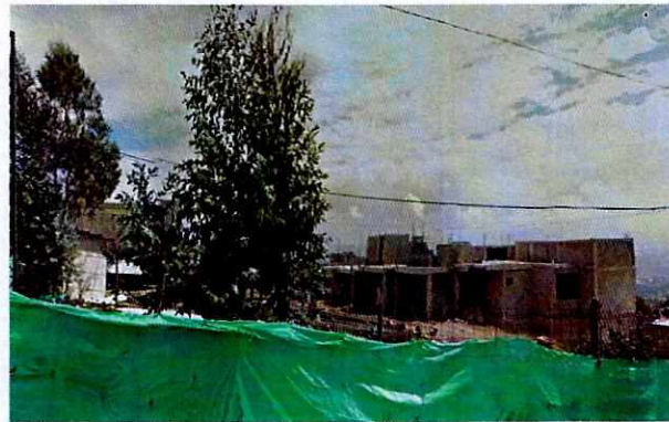
Foto N° 3.- Proyecto ARAWI: Estado de avance de la construcción.
