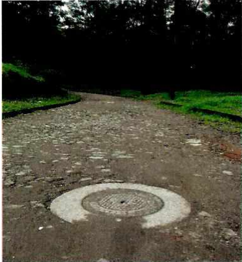
Pozo de alcantarillado
