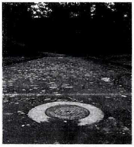
Pozo de alcantarillado
