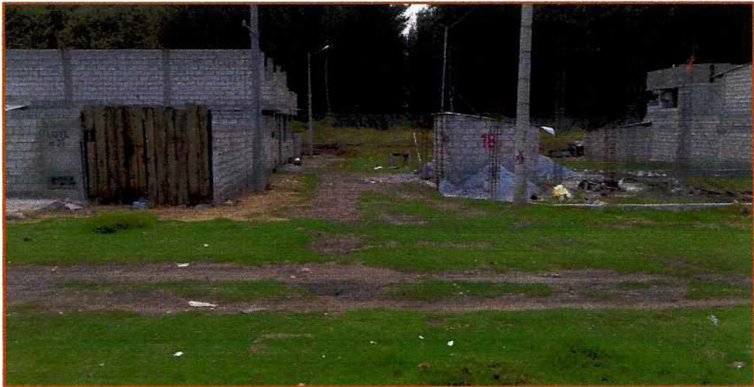
Fotografía 6: verificación de la sección de la calle "s/n"
