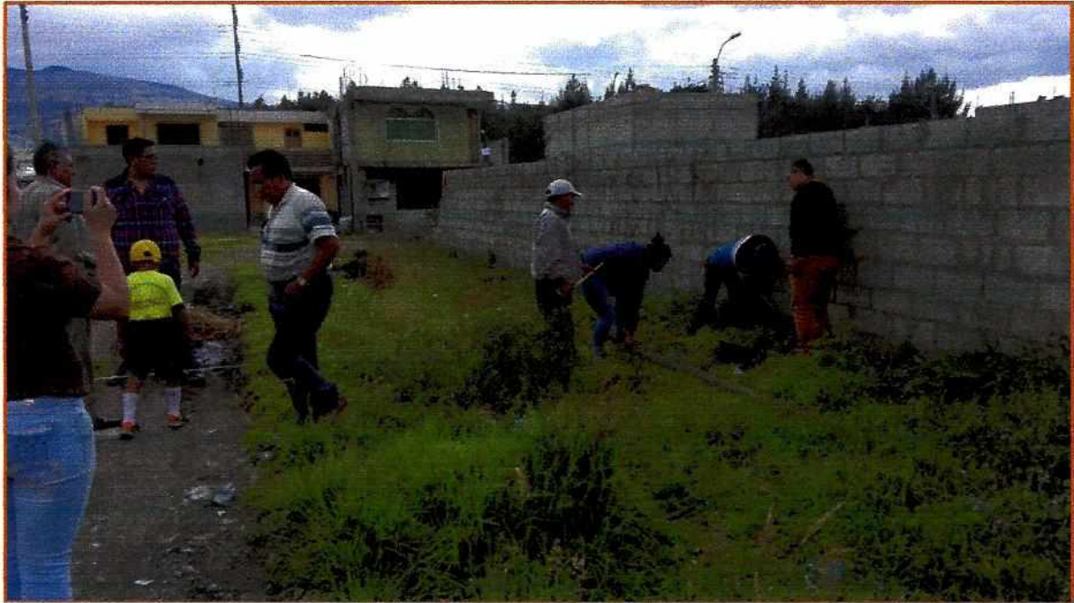
Fotografía 3: verificación de la sección de la calle "s/n"
