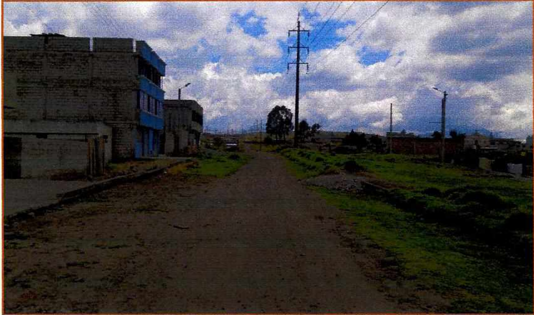
Fotografía 5: verificación de la sección de la calle "s/n"
