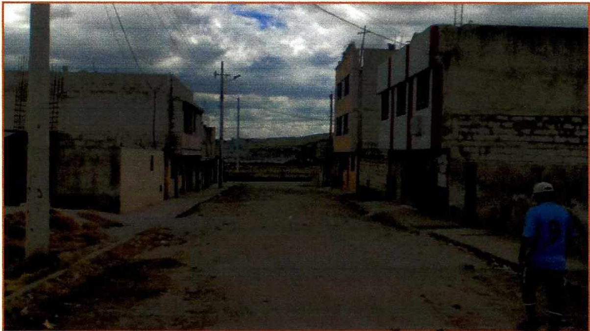
Fotografía 4: verificación de la sección de la calle "s/n"
