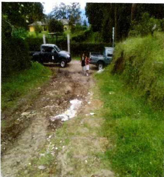
Inicio vía (tramo 1)
