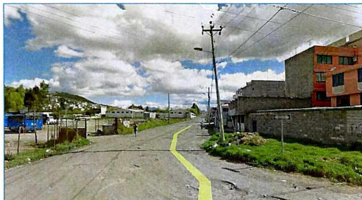
Tramo inicial desde la Calle Antonio Villanueva
